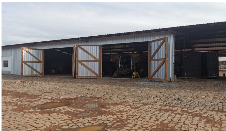
IMAGEM 3 - Instalações provisórias para manutenção de Vtr Guarani no 9º B Log.
