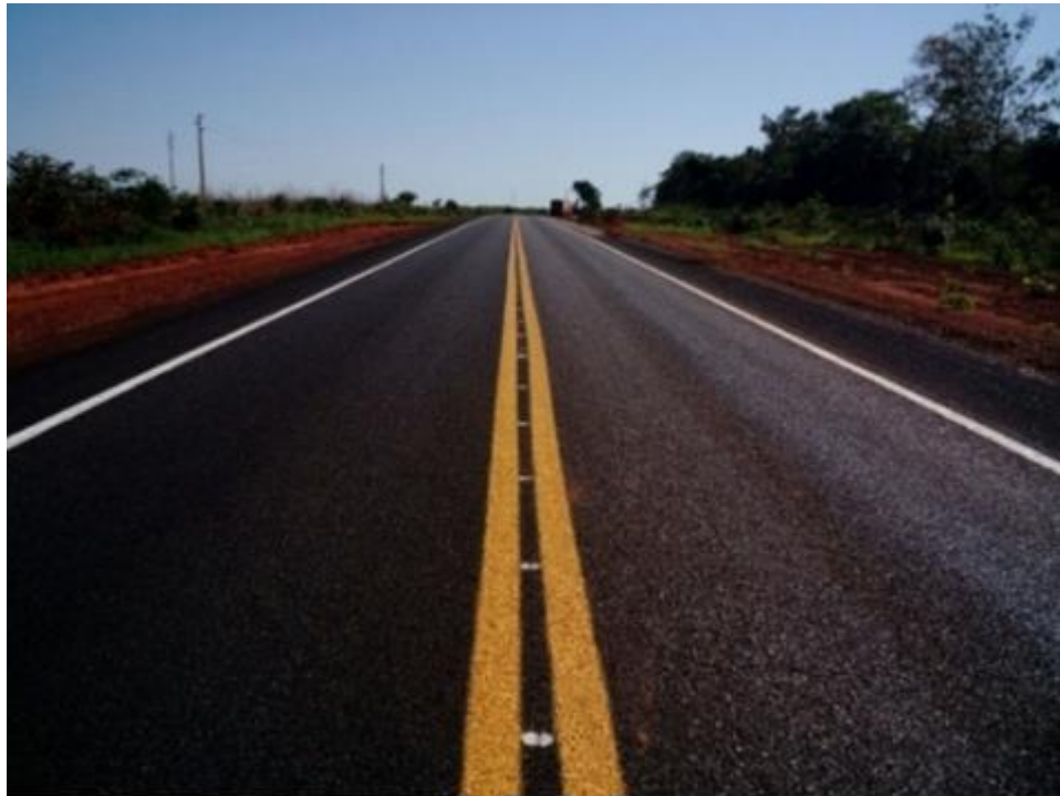
Figura 2: Rodovia pavimentada com CAUQ
