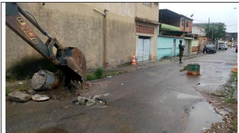
**Imagem 01** – Obstáculos de tonéis metálicos concretados
