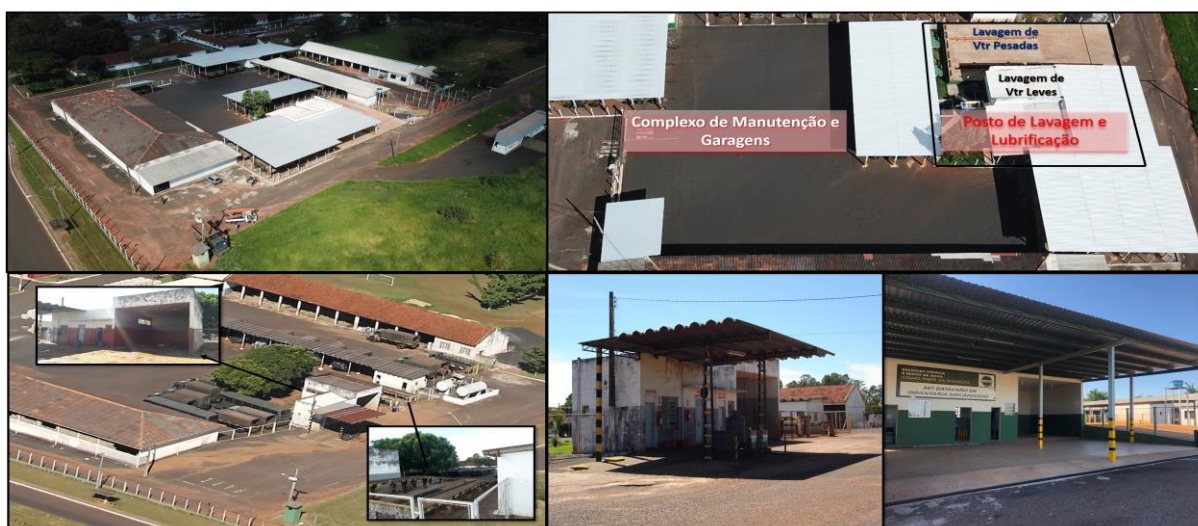
Figura 12 - PLL após a readequação
