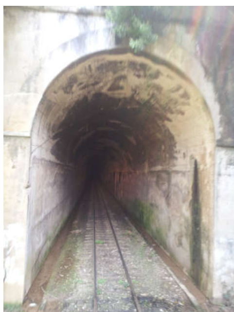
Figura 16 – Túnel existente no trecho de Tatuí-SP
