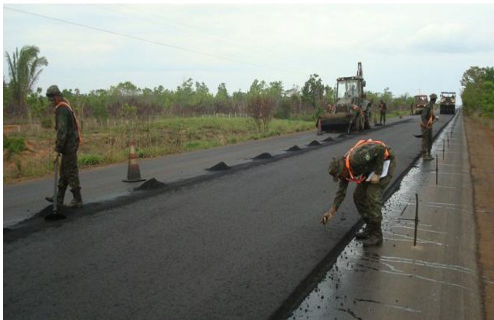
Figura 2: Obras na BR – 319. Fonte: 5º Batalhão de Engenharia de Construção.
