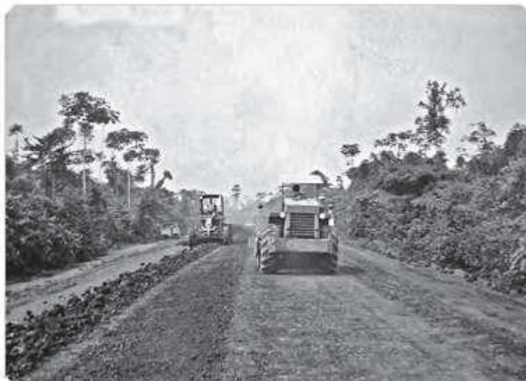
Figura 3: Obras na BR-364. Fonte: BRASIL, 2017a, p. 142.
