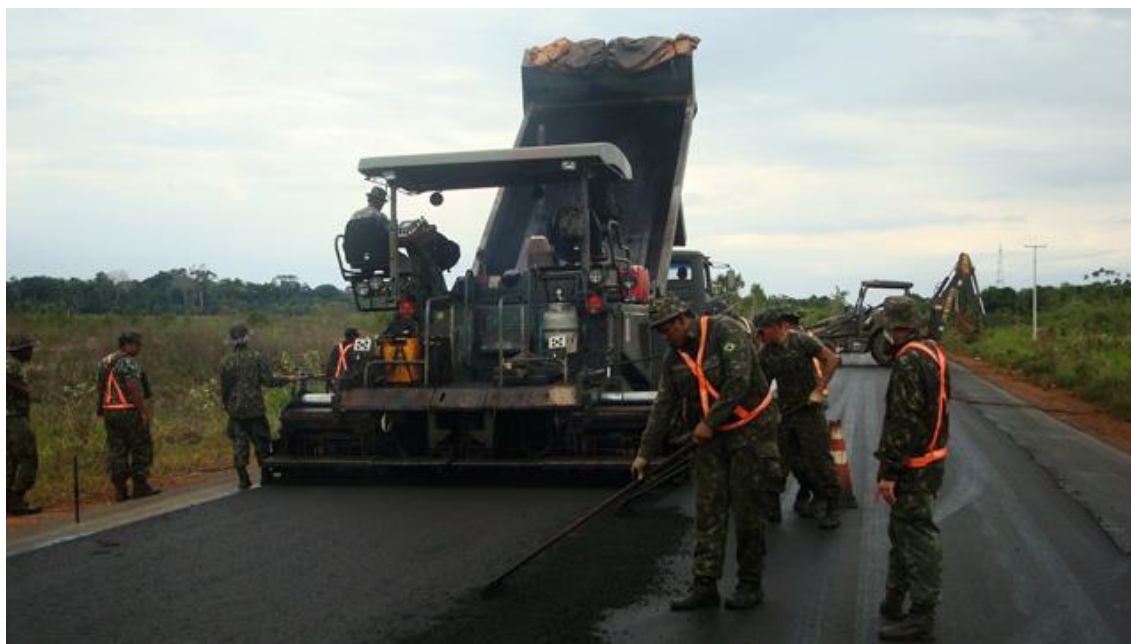
Figura 1: Obras na BR – 319. Fonte:5º Batalhão de Engenharia de Construção.
