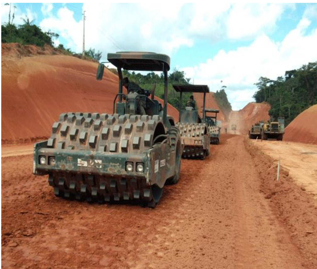
Figura 4: Obras na BR – 163. Fonte: Arquivo do 5º Batalhão de Engenharia de Construção.
