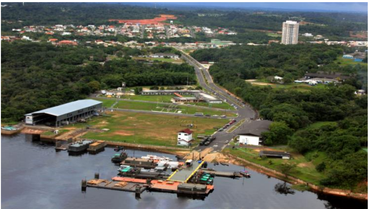
Figura 2 – Vista aérea do Porto do CECMA
