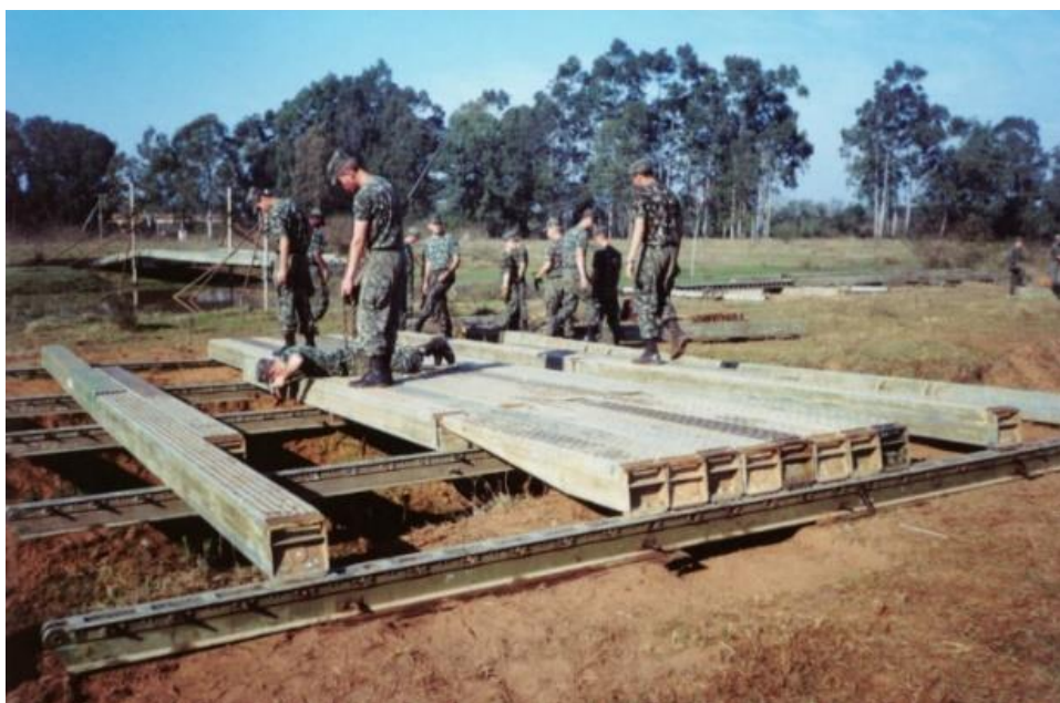
FIGURA 8 – Ponte M4T6 biapoiada durante a montagem Fonte: DINIZ, 2018
