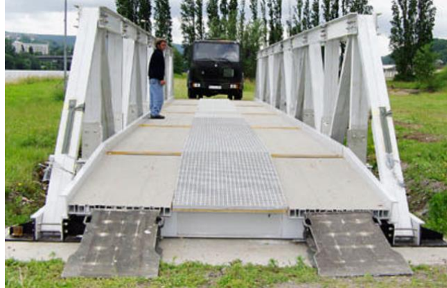
FIGURA 13 – Ponte montada e passagem de viatura CI 16 Fonte: SEDLACEK & TRUMPF, 2004
