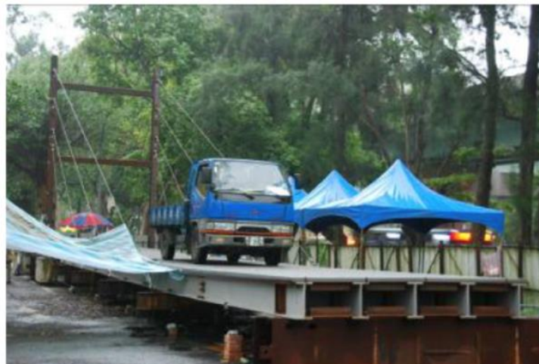
Figura 32 – Passagem do veículo sobre a ponte estaiada Fonte: YEH et al, 2016
