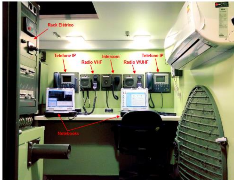
FIGURA 6 – Vista Geral Interna Fonte: SAVIS, 2015, p. 17
