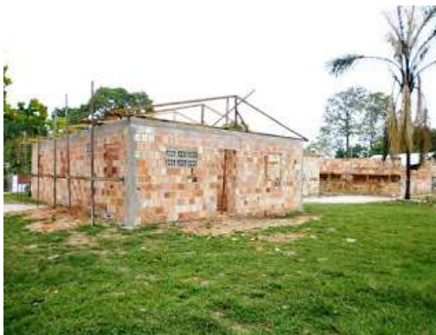
Figura 25 - Casa em Construção com Blocos Cerâmicos em Tabatinga.
