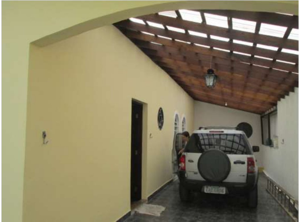
Figura 36 - Cobertura de Telhado Translúcido.
