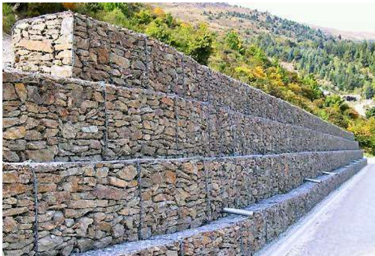
Figura 26 - Estrutura de Gabião.
