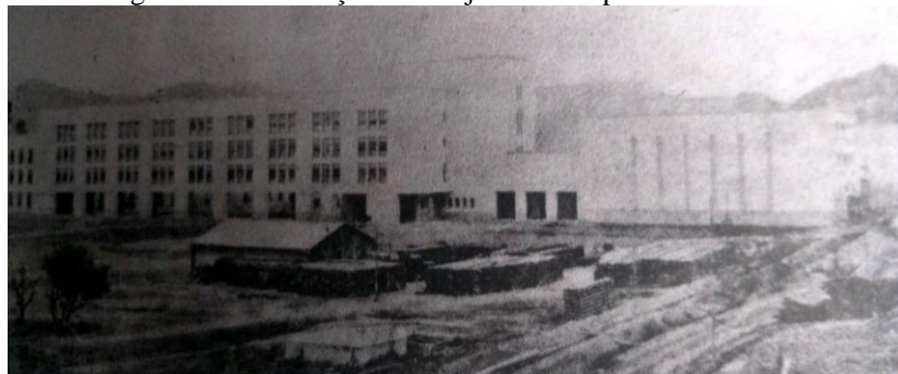
Figura 10 - Construção do Conjunto Principal vista de frente
