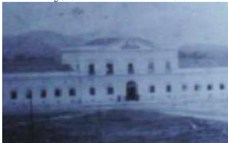
Figura 3 - EMR antes da reforma de 1920
