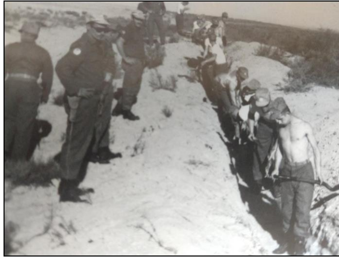
Figura 5- Soldados recuperam uma valeta coberta de areia devido às tempestades da região
