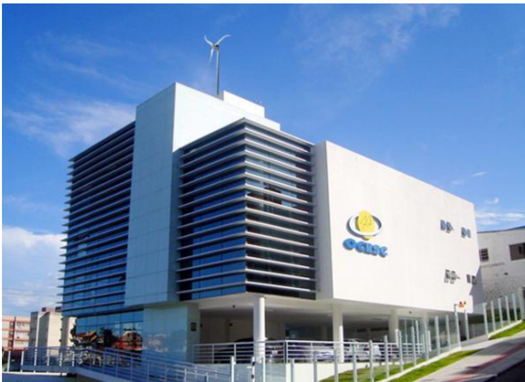
FIG 3.1 – Aero gerador de 2.4 kW no topo de um edifício (Energiapura, 2013)
