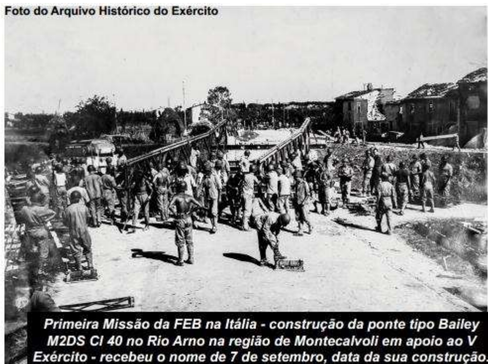
Figura 2: Militares do exército construindo ponte bailey durante a segunda guerra mundial.
