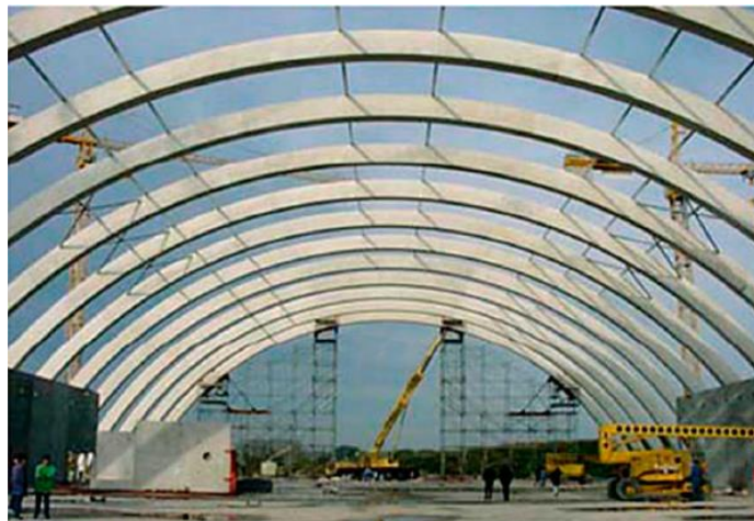
FIG. 2.1 – Foto mostrando arcos feitas de pré-moldados de CAA. (TUTIKIAN, 2008)
