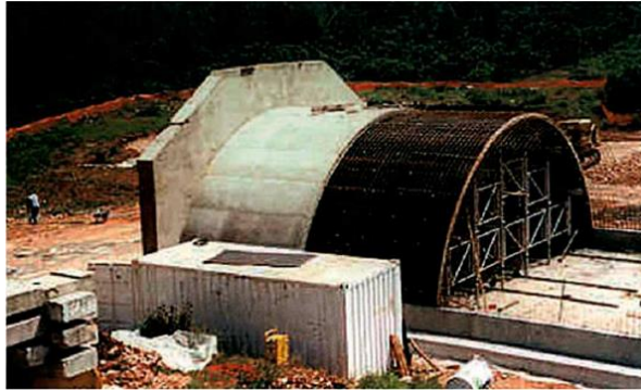
FIG. 2.2 – Estrutura em forma de iglu concretada com CAA. (TUTIKIAN, 2008)
