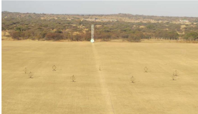
Figura 13 – Campo de Antenas HF-DF instalado numa área de teste
