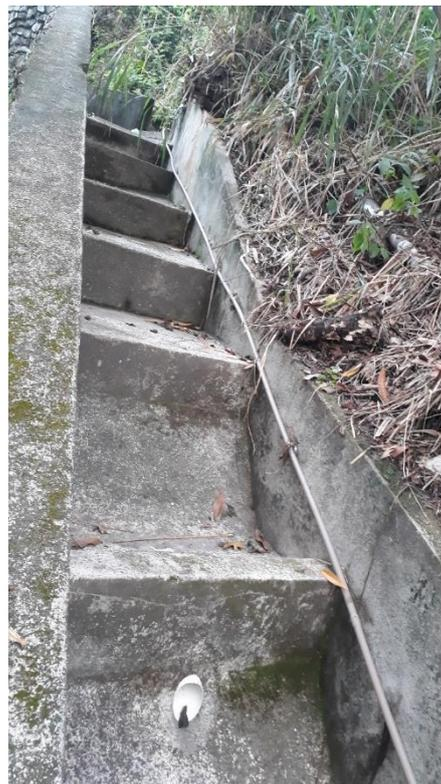
FIG. 10 - Escada de dissipação de energia.
