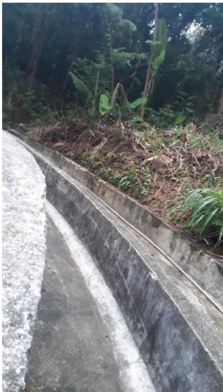
FIG. 9 – Canal de condução de água pluvial
