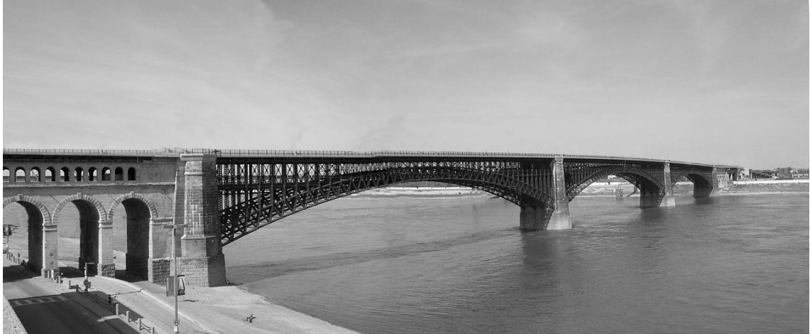
FIG. 2.4 - Eads Bridge, St Louis, Estados Unidos
