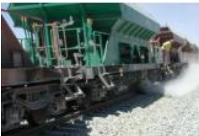
Figura 25 - Lastro novo é colocado sob a grade
