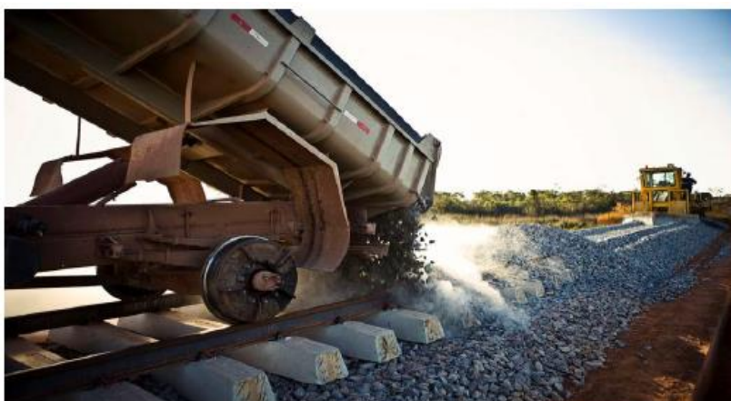
Figura 12 - Aplicação de lastro utilizando caminhão ferroviário
