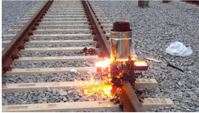
Figura 14 - Solda aluminotérmica
