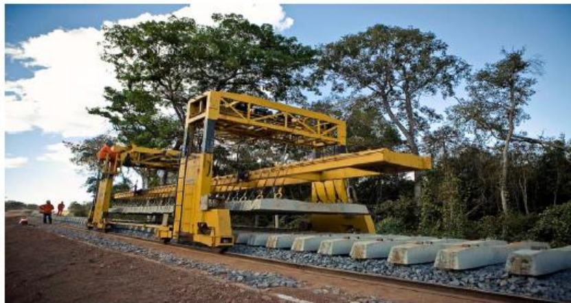
Figura 9 - Descarga dos dormentes na plataforma por meio de sistema de pórticos Fonte: Sistema de Pórtico. Disponível em: < www.tiisa.com.br >. Acesso em: 25 de maio de 2017.
