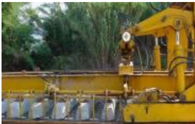
Figura 24 - Dormentes novos são posicionados
