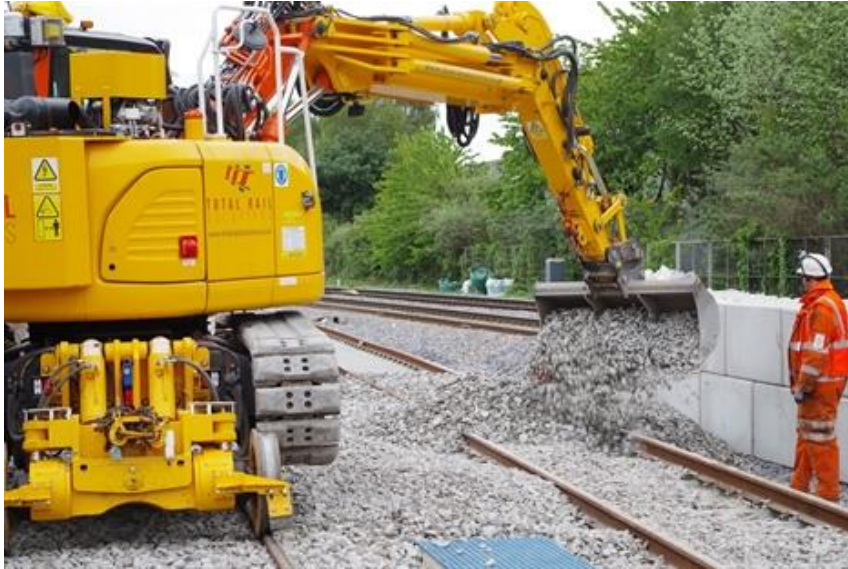
Figura 35 - Utilização de escavadeira para colocação do lastro
