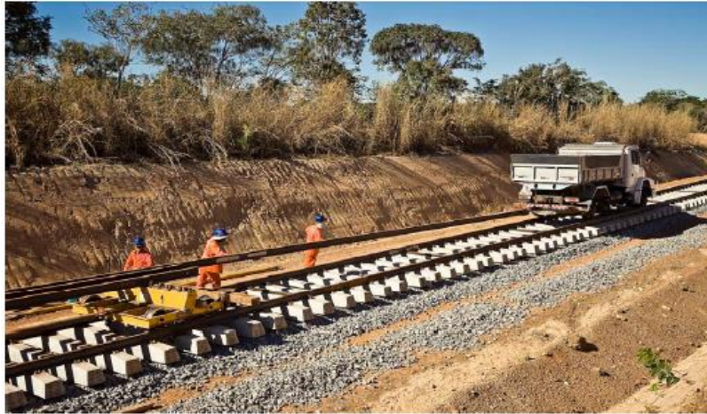
Figura 10 - Posicionamento dos trilhos por meio de caminhão ferroviário
