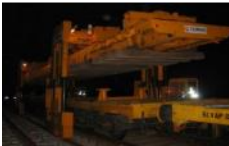
Figura 22 - Retirada da grade pelos guindates de pórtico
