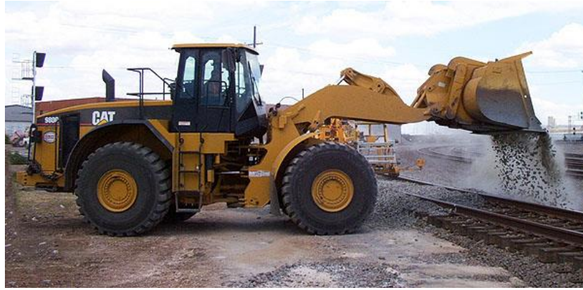
Figura 28 - Pá-carregadeira realizando a colocação de lastro na via.
