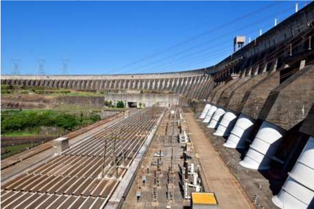
Figura 6 – Usina de Itaipú.
