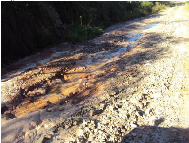
Figura 2 – Erosão das estradas no interior do CISM.
