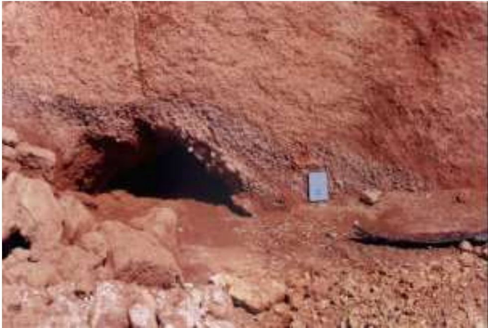
Figura 3.3 Exemplo de nível de concreções ferruginosas. (CPRM, 2010)
