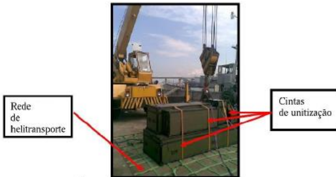
Figura 4.12: Embarcações EDCG Guarapari – guindaste para içamento de carga
