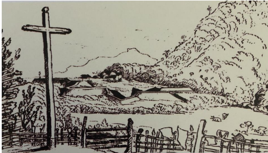
Figura 1. Forte do Campinho. Uma das Fortificações construídas em 1822, a qual protegia os acessos à Cidade do Rio de Janeiro contra uma possível invasão desencadeada por terra, passando pelo Vale do Irajá. FONTE: Castro. Muralhas de Pedra, 2009.
