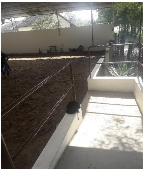
Figura 14: Rampa de acesso ao cavalo do CERVIM 2. Fonte: O autor.
