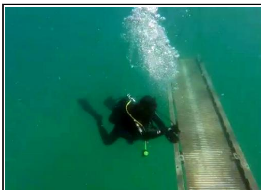
Fig 2-1: Refluturação de Paineis de Passadeira utilizando mergulhadores
