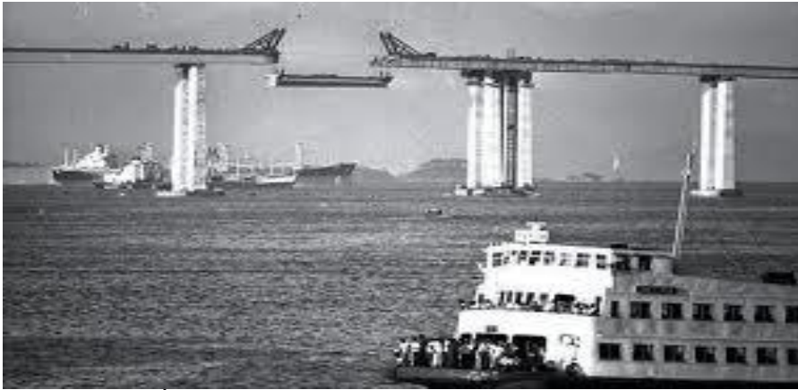
Figura 2 - Fase de construção da superestrutura da ponte
