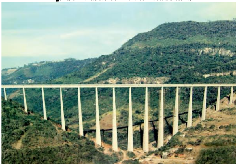
Figura 5 - Viaduto do Exército Roca Sales/RS
