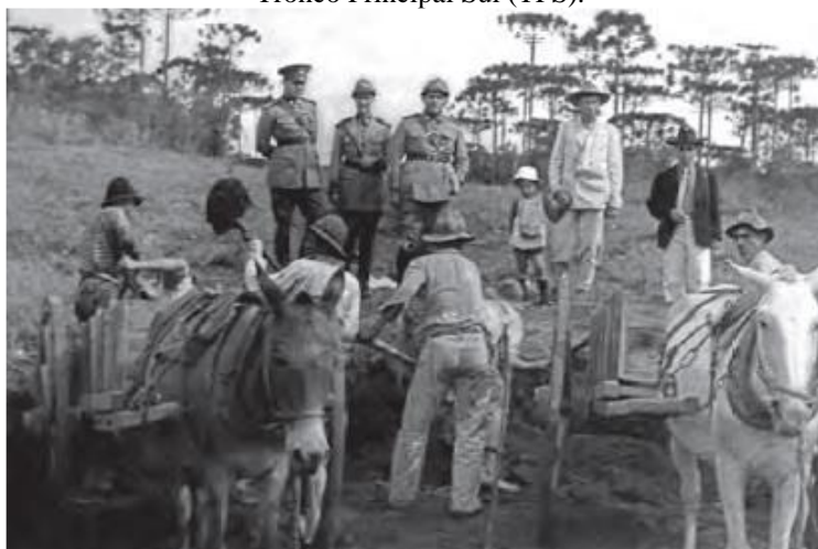
Figura 6 - Terraplenagem manual, com auxílio de animais, executada por militares do 2º B Fv, nas obras do Tronco Principal Sul (TPS).
