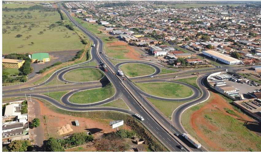
Figura 5: Construção rodoviária, em Uberaba - MG
