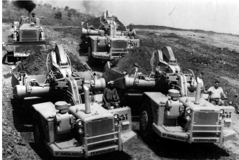
Figura 12: Movimentação de material pelo maquinário do 2º BFv
