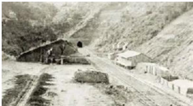
Figura 7: Construção de túnel (obra de arte) ferroviário, em Lages - SC
