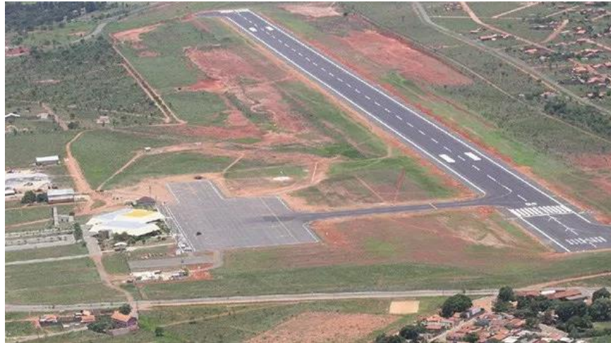
Figura 8: Construção de pista de pouso, em Pirenópolis – GO
