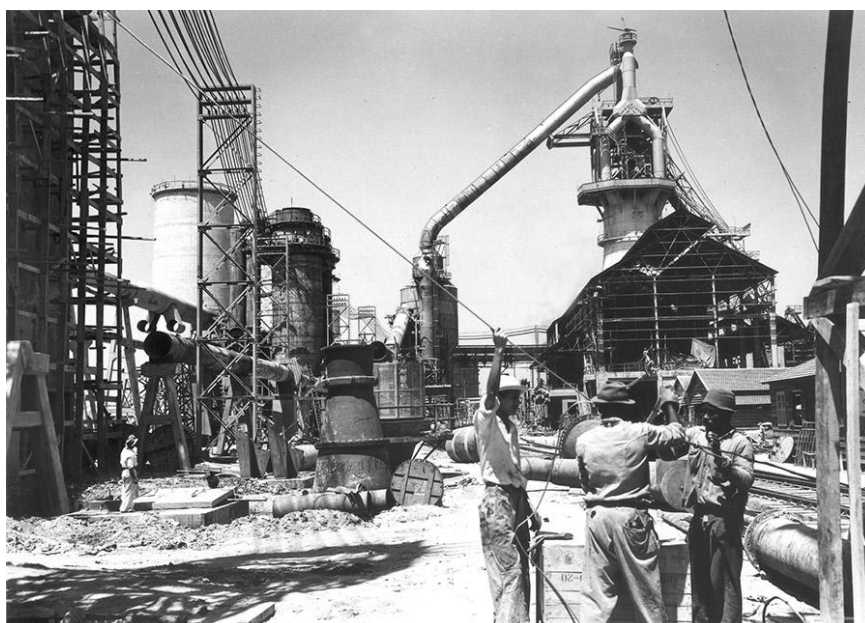
Figura 10: Obras da construção da usina de Volta Redonda, da Cia. Siderúrgica Nacional
