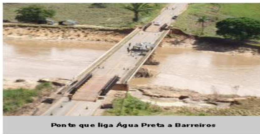
Figura 18 - Ponte que liga localidades de ÁGUA PRETA-PE E BARREIROS-PE
