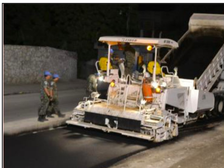
Figura 09 – Asfaltamento de vias Fonte: BRAENGCOY
