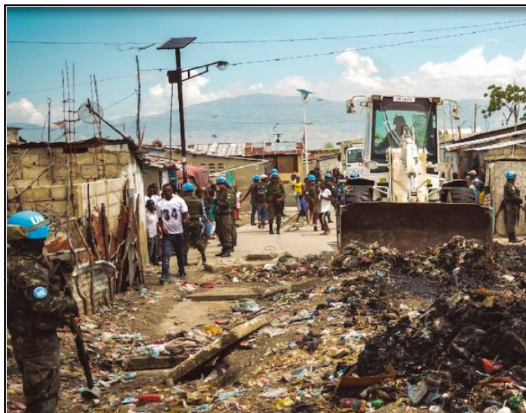
Figura 08 – Desobstrução de vias Fonte: BRAENGCOY
