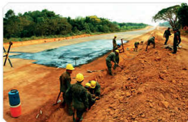
Imagem 13 - Obras na BR-163 (2013)
