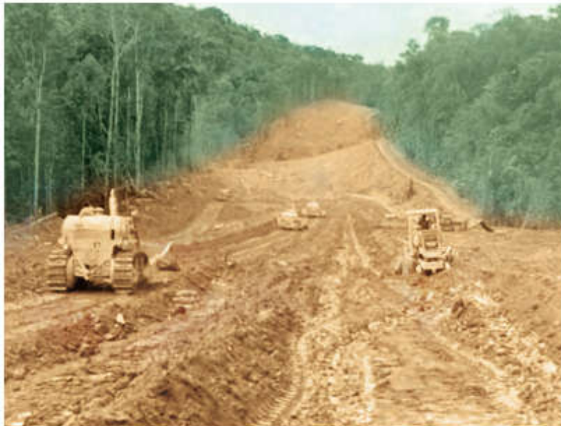
Imagem 3 - Serviços de terraplenagem na BR-174
