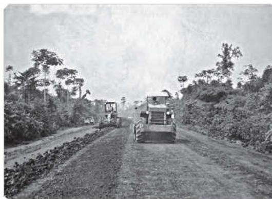
Imagem 1 - Obras na BR-364
