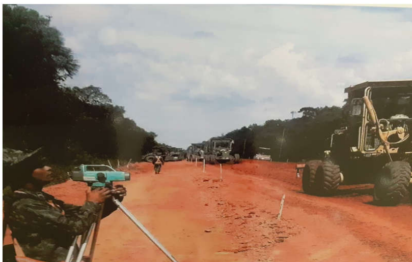
Imagem 6 - Terraplenagem na BR-319
