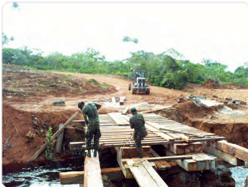
Imagem 15 - Recuperação de ponte de madeira
