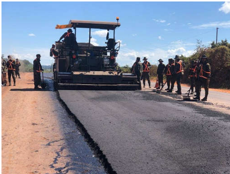
Imagem 14 - Obras atuais na BR-163 (2019)
