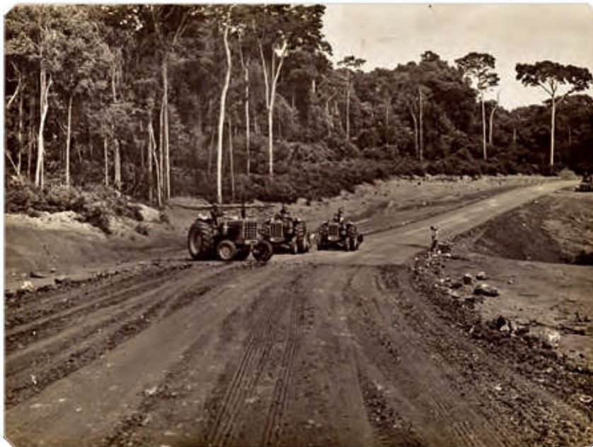
Imagem 11 - Obras na BR-163 (década de 1970)
