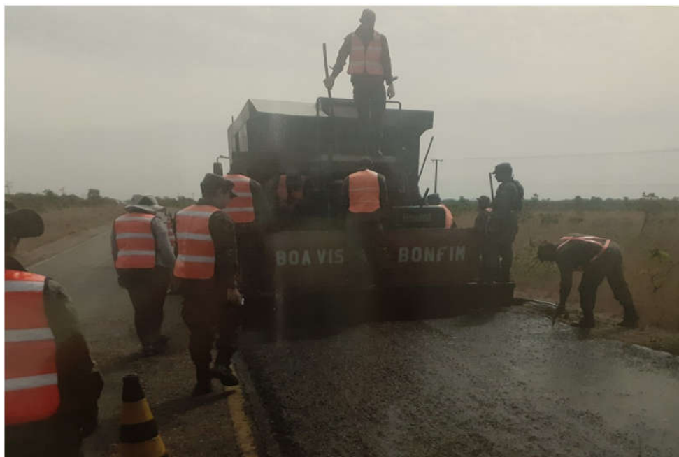
Imagem 5 - Lançamento de microrrevestimento asfáltico na BR-401
