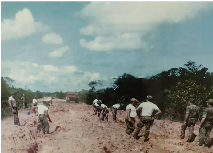
Imagem 4 - Conservação e manutenção da BR-174
