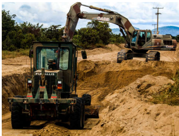
Imagem 8 - Terraplenagem na BR-432
