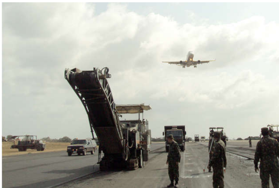
Imagem 10 - Obra no aeroporto de Rio Branco
