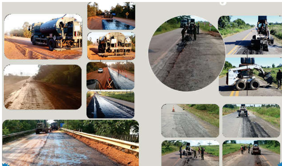
Figura 6 - Atuais obras na BR-364
