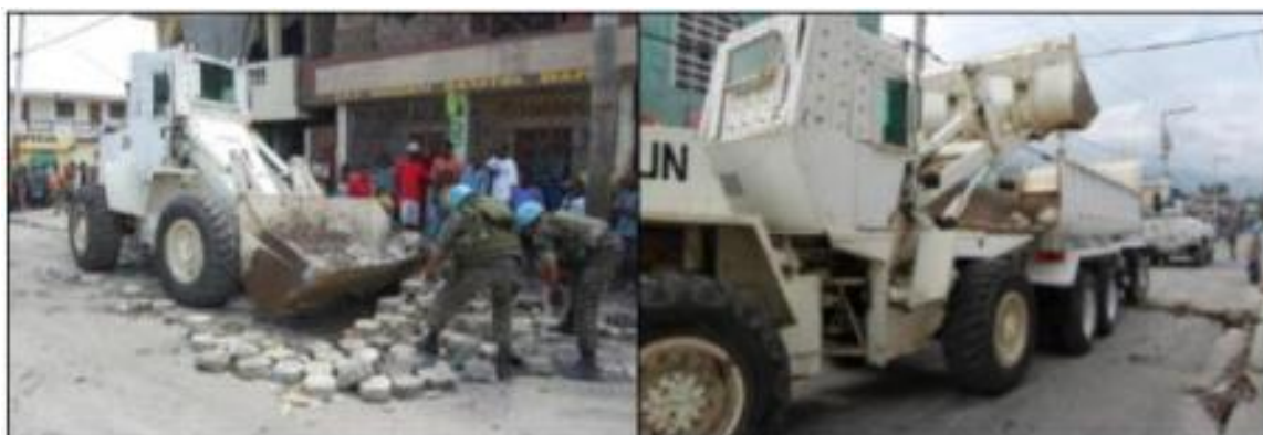
FIGURA 15: Remoção de Escombros
