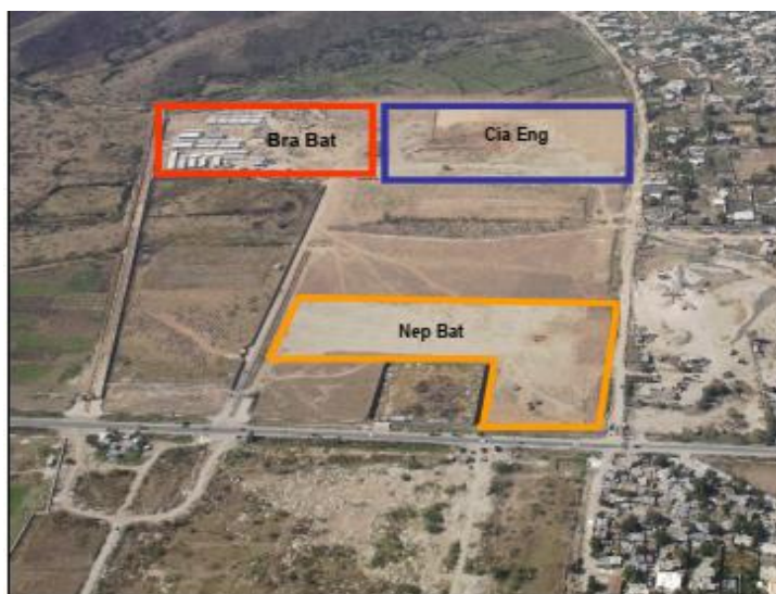
Figura 18: Construção do Campo Charlie.
