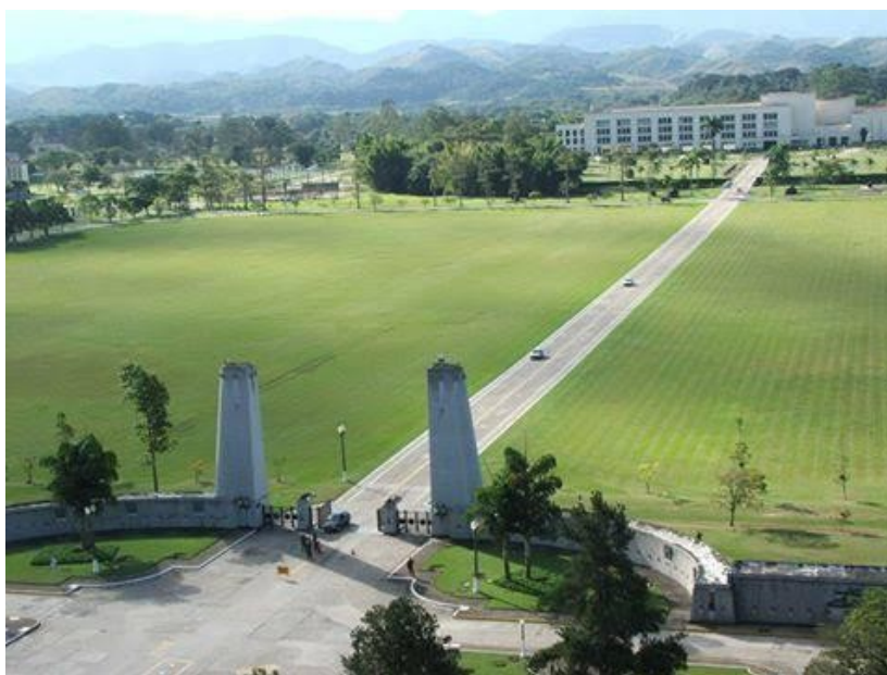
Figura 1 – Entrada da AMAN (Portão Monumental)
