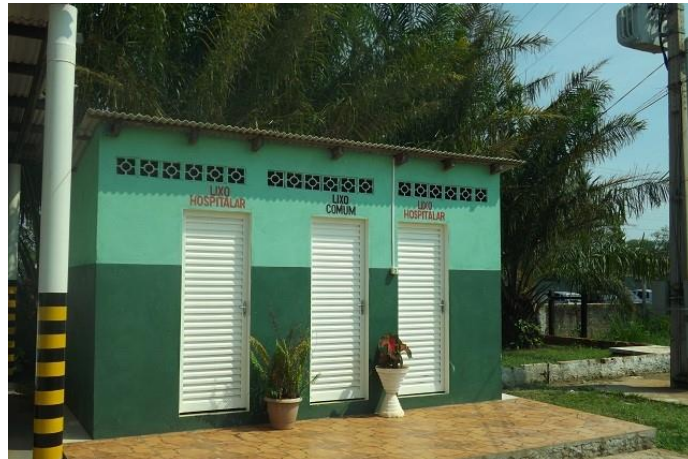
Foto 9: Depósito resíduos sólidos
