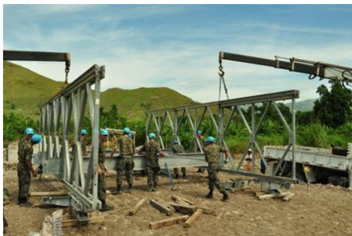
Figura 4 – Construção de ponte feita pela Engenharia do Exército Brasileiro
