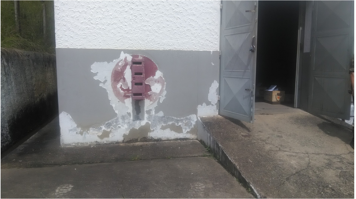
Figura 5 – Portas duplas e acesso elevado para evitar inundação
