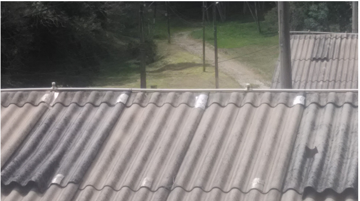
Figura 6 – Telhado de amianto e sistema de esguicho para controle da temperatura
