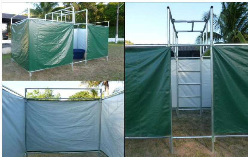
Figura 4: Parte estrutural do P Ban com lona.
