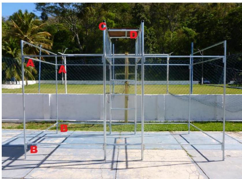
Figura 6: Encaixes do P Ban.
