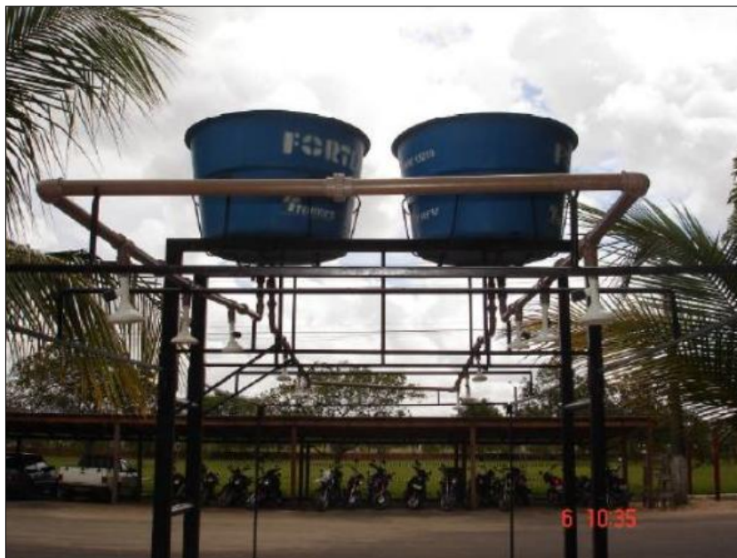
Figura 12: Estrutura hidráulica do P Ban.
