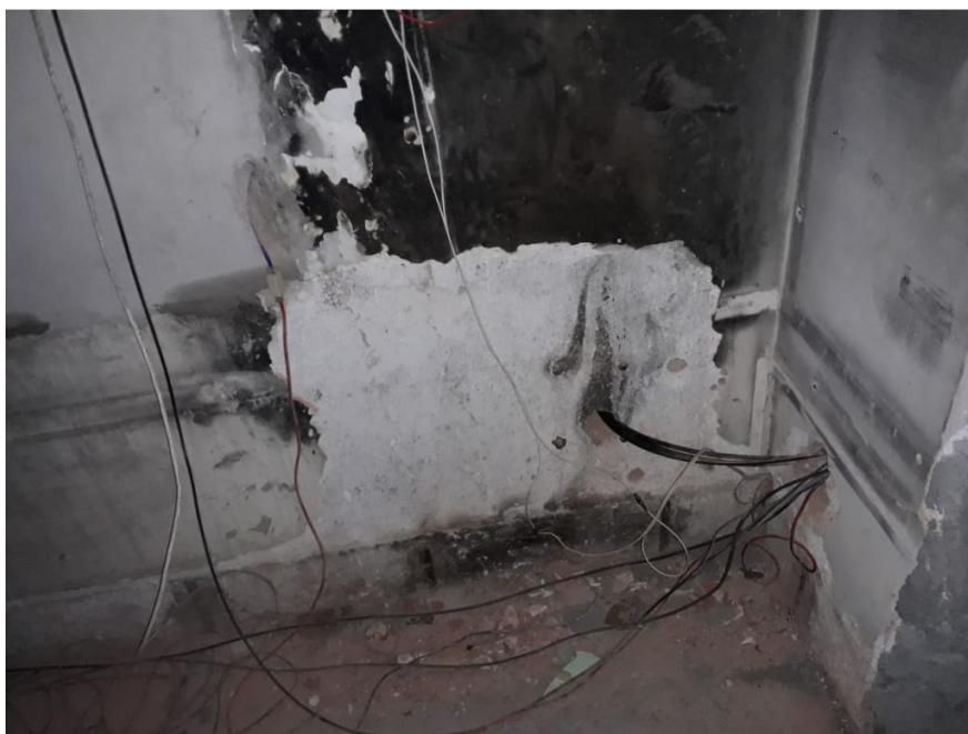
Figura 3 – Sala dos servidores
