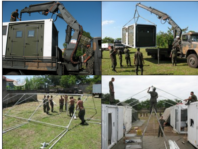
Figura 7: Transporte e montagem da estrutura do Hospital de Campanha
