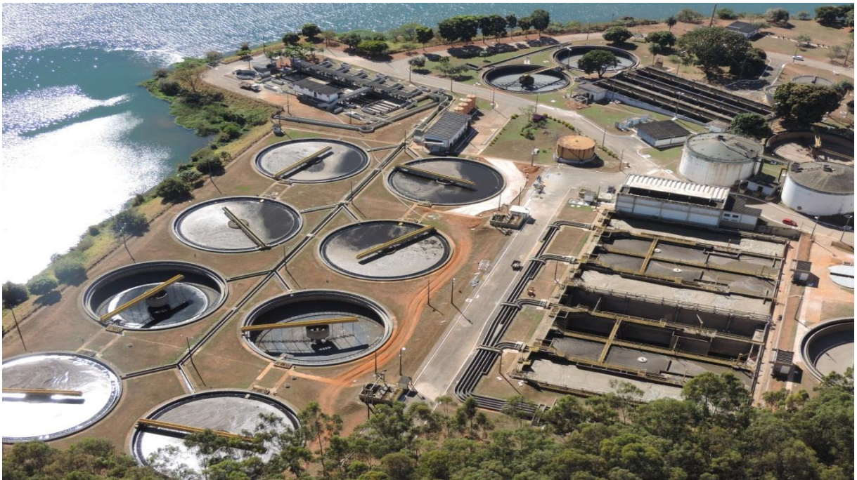
Fig 1 – Estação de tratamento de esgoto de Brasília, reconhecimento durante as Olimpíadas de 2016. Fonte: o autor.
