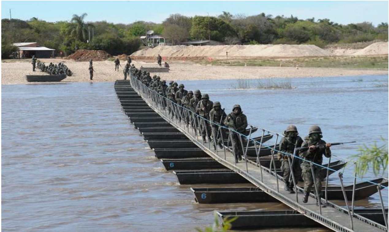
Imagem 01 – Militares do 9ºBECmb em operação com a Passadeira Flutuante de Alumínio
