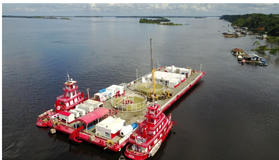
Figura 25 – Embarcação de Lançamento do Cabo Óptico com Dois Cestos
