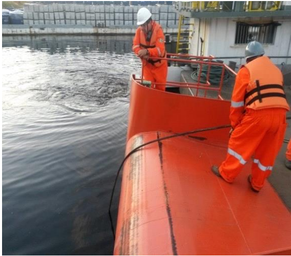
Figura 5 – Lançamento do Cabo Óptico Subfluvial no Rio Negro
