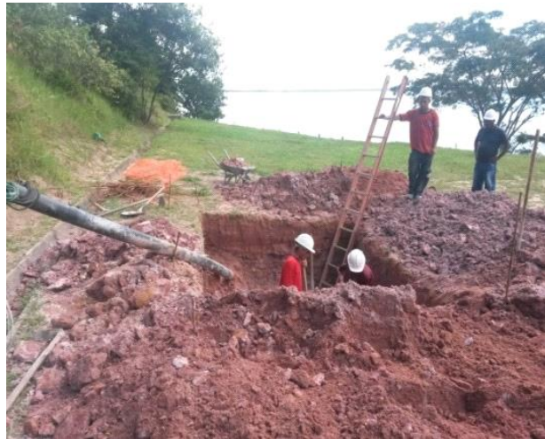
Figura 6 – Construção da Caixa de Ancoragem no CECMA
