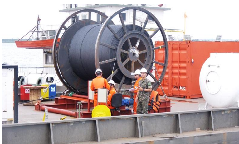
Figura 4 – Balsa de Lançamento dos Cabos de Fibra Óptica
