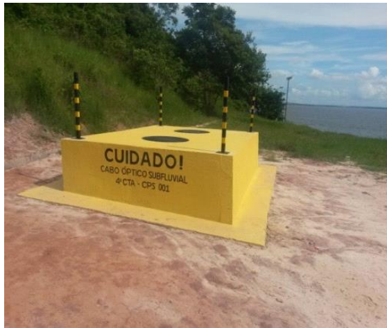
Figura 8 – Caixa de Ancoragem no CECMA
