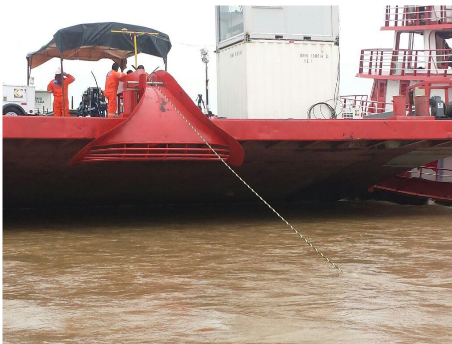
Figura 18– Lançamento do Cabo Óptico no Rio Solimões
