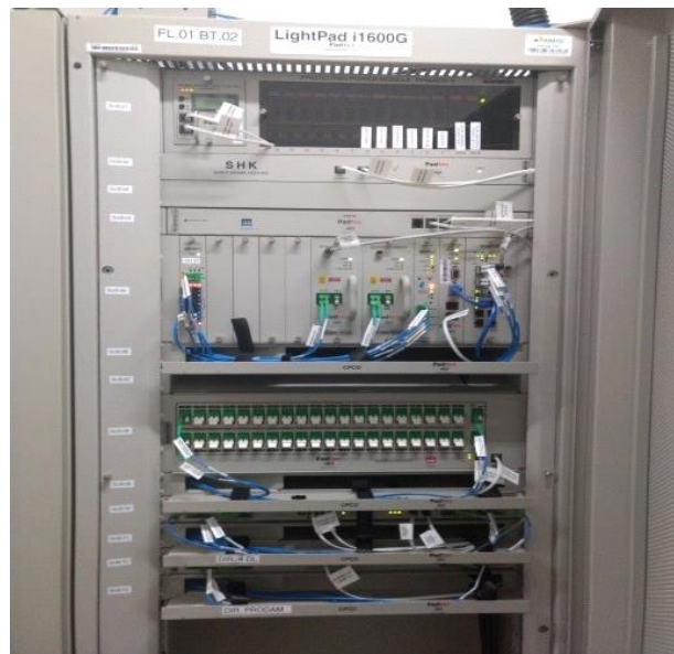
Figura 9 – Equipamentos DWDM
