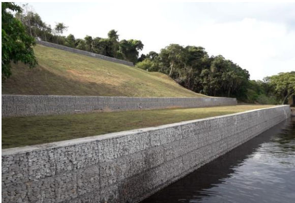
FIGURA 13 – Contenção de talude Fonte: 9º DN
