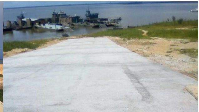
FIGURA 30 – Rampa de Acesso Fonte: CRO/12
