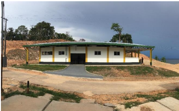
FIGURA 29 – Pavilhão Manutenção Fonte: CRO/12
