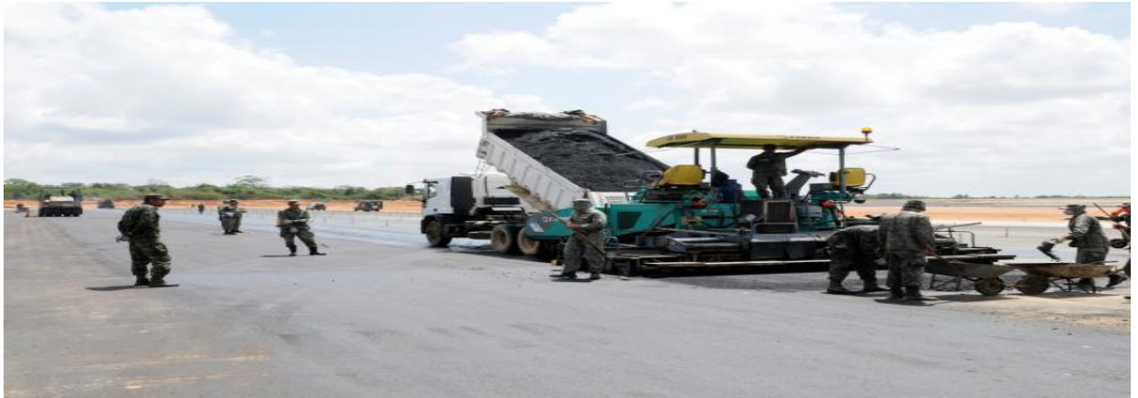
Figura 11: Descarga do material asfáltico na pavimentadora.
