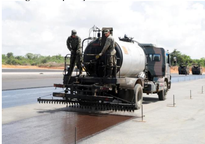
Figura 8: Aplicação do material Betuminoso
