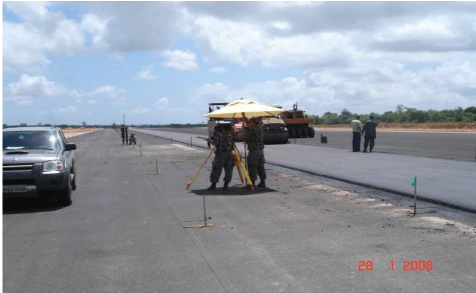
Figura 5- Demarcação topográfica da área de aplicação
