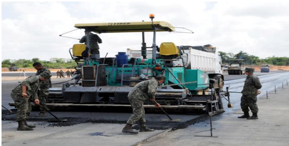
Figura 12: Lançamento de CBUq no trecho que recebeu pintura de ligação.
