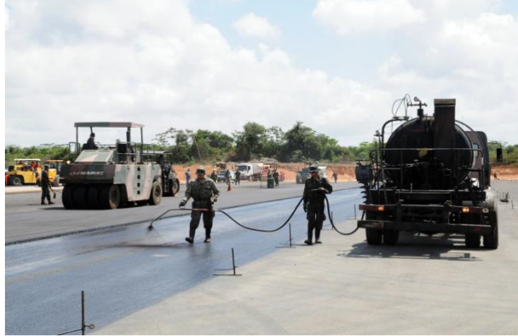
Figura9:Aplicação do material Betuminoso com espargidor
