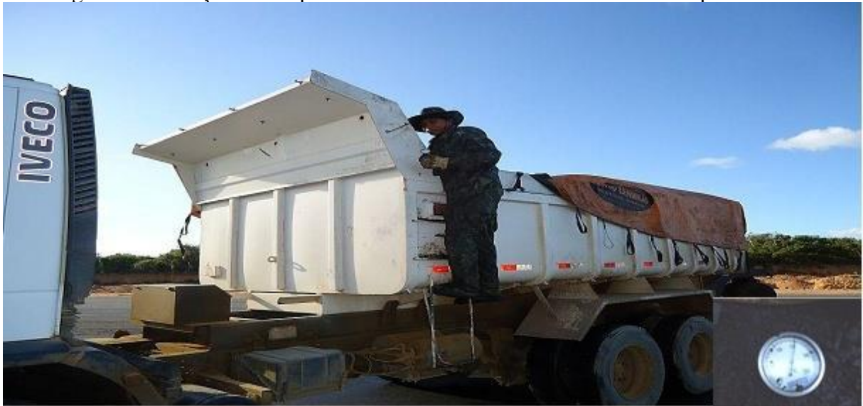
Figura 10: Aferição da temperatura do material betuminoso antes do espalhamento
