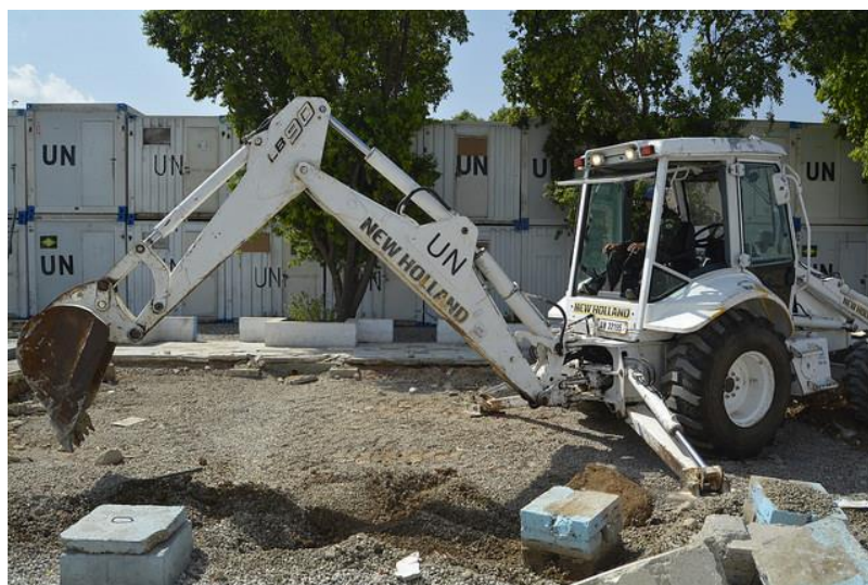
Figura 7 - Limpeza de área edificada
