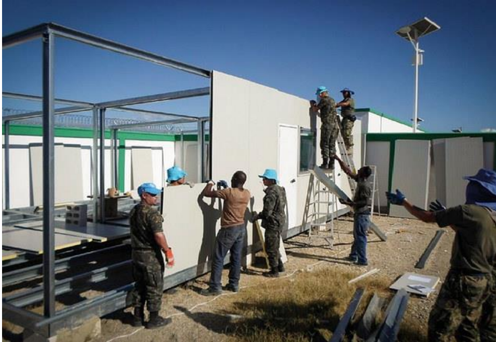
Figura 4 - Cia E F Paz realiza trabalhos de construção de Corimec. Fonte: www.exercito.gov.br/03ativid/missaopaz/minustah/noticias
