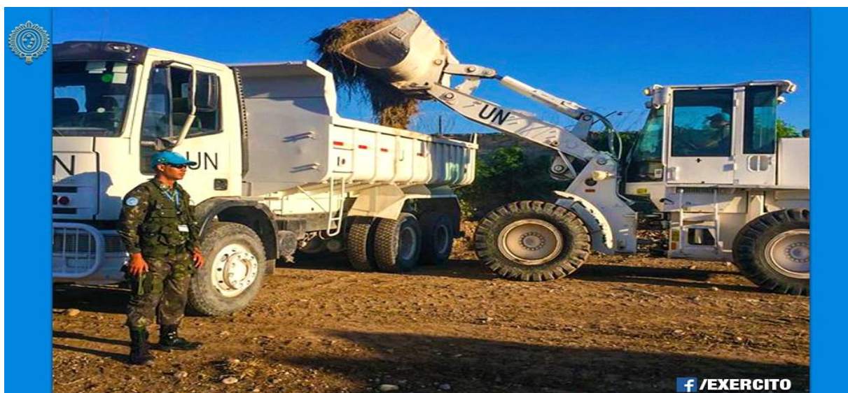
Foto 3: Trabalhos de Engenharia de Construção na MINUSTAH – fonte DEC
