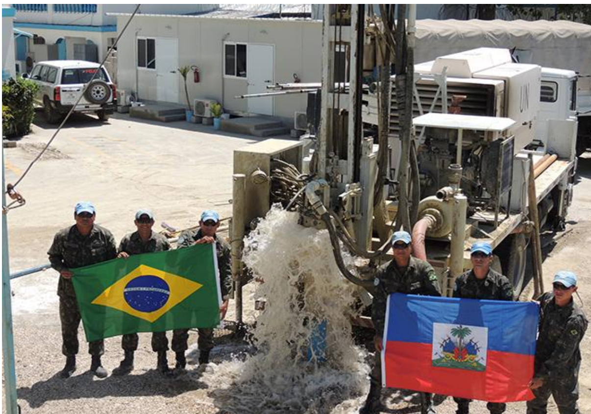
Figura 12: BRAENGC0Y executando trabalhos de perfuração de poços
