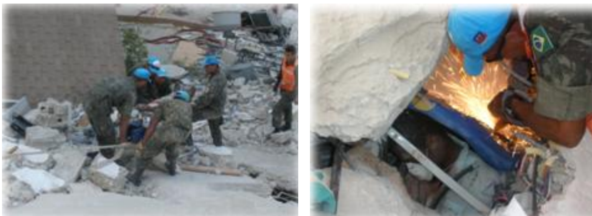
Figura 15: Trabalhos da BRAENGOCY executados após o terremoto ocorrido em 2010.
