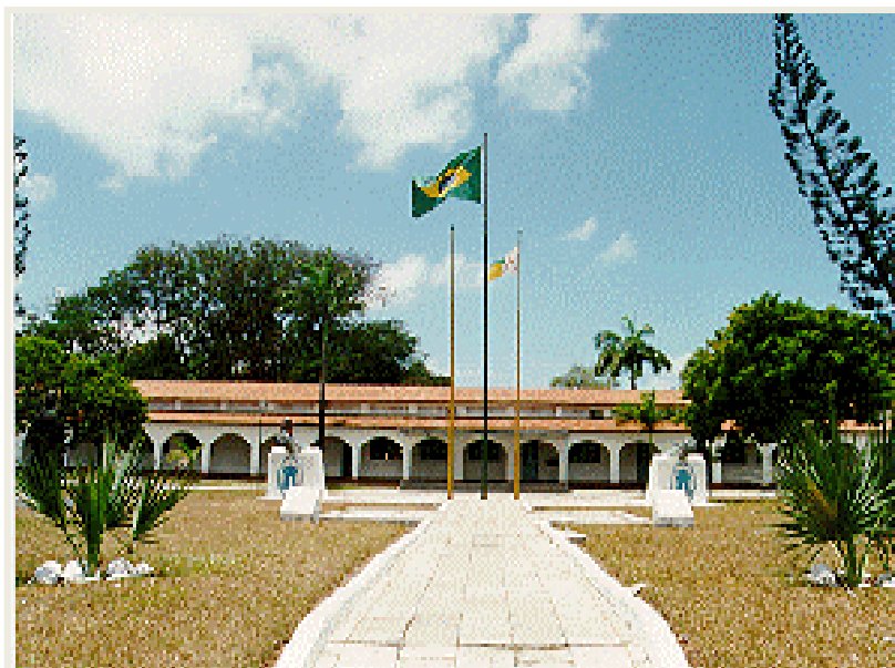
Figura 10 - Pavilhão de Cmdo do 1º Grupamento de Engenharia Fonte: COE/1º Gpt E
