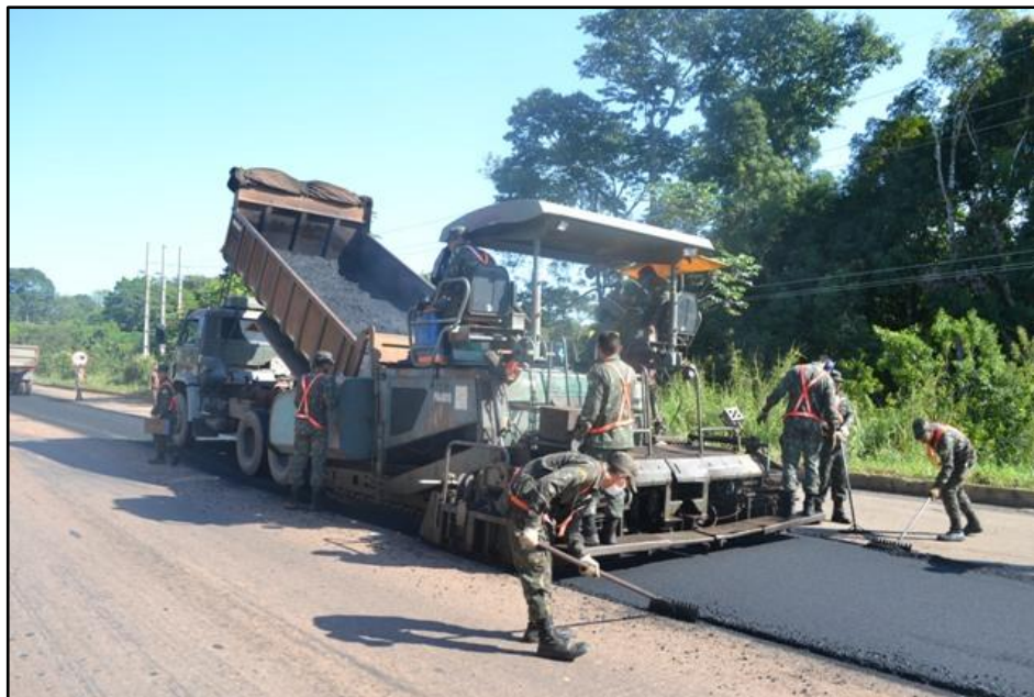
Figura 03: Operação de engenharia pertencente ao Contrato de Restauração e Manutenção da Rod BR 364.
